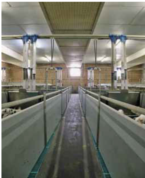
Die Rieselkanallüftung eignet sich dank der geringen Luftgeschwindigkeiten gut für die Ferkelaufzucht.
